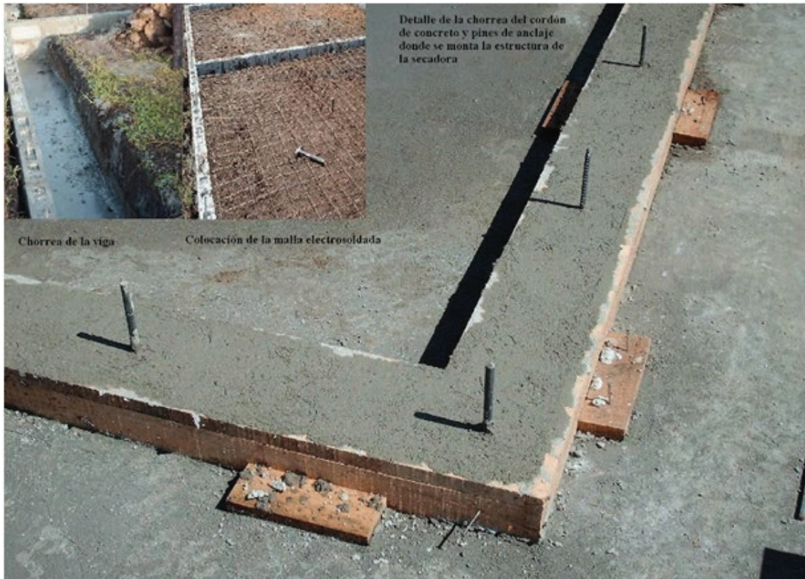
DETALLE DEL CIMIENTO Y COLOCACIÓN DE MALLA ELECTRO SOLDADA.
