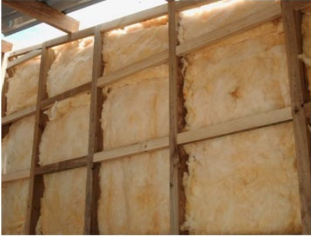
INSTALACIÓN DE FIBRA DE VIDRIO.
