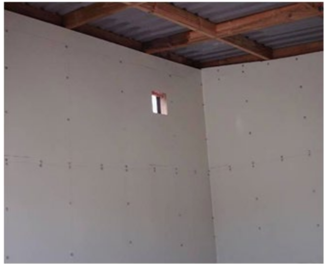
FIGURA 4. A LA IZQUIERDA SE OBSERVA EL USO DE LA FIBRA DE VIDRIO COMO AISLANTE ENTRE FORROS. A LA DERECHA SE OBSERVA LA MISMA PARED INTERNA YA FORRADA INTERNAMENTE.
