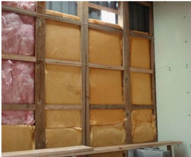
FIGURA 4. A LA IZQUIERDA SE OBSERVA EL USO DE LA FIBRA DE VIDRIO COMO AISLANTE ENTRE FORROS. A LA DERECHA SE OBSERVA LA MISMA PARED INTERNA YA FORRADA INTERNAMENTE.
