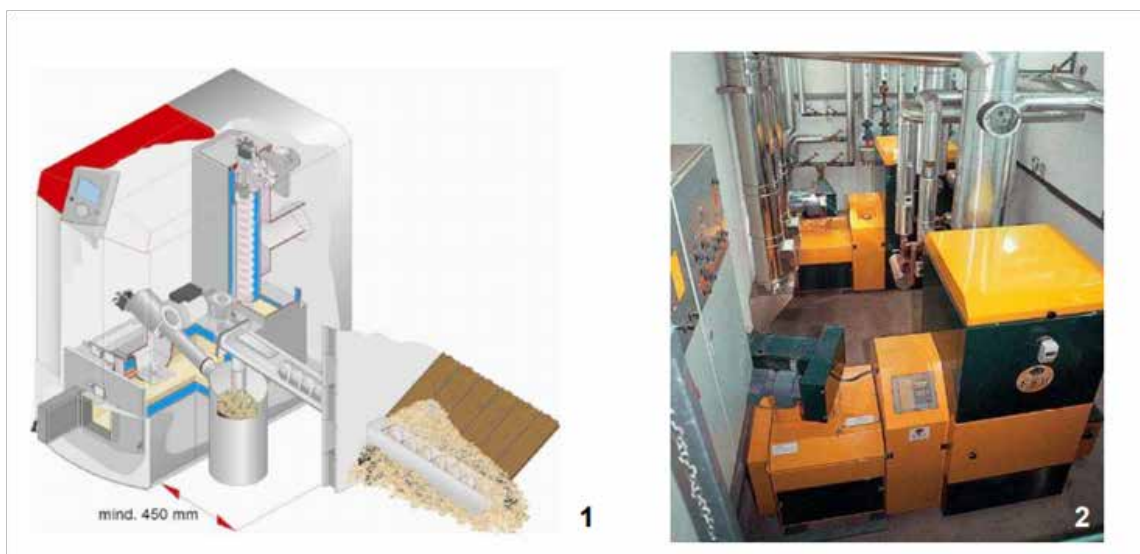
FIGURA 1. CALDERAS DE BIOMASA PARA CALEFACCIÓN DE EDIFICIOS (1) CALDERA DE 14,9 KW, (2) CALDERA <500KW
