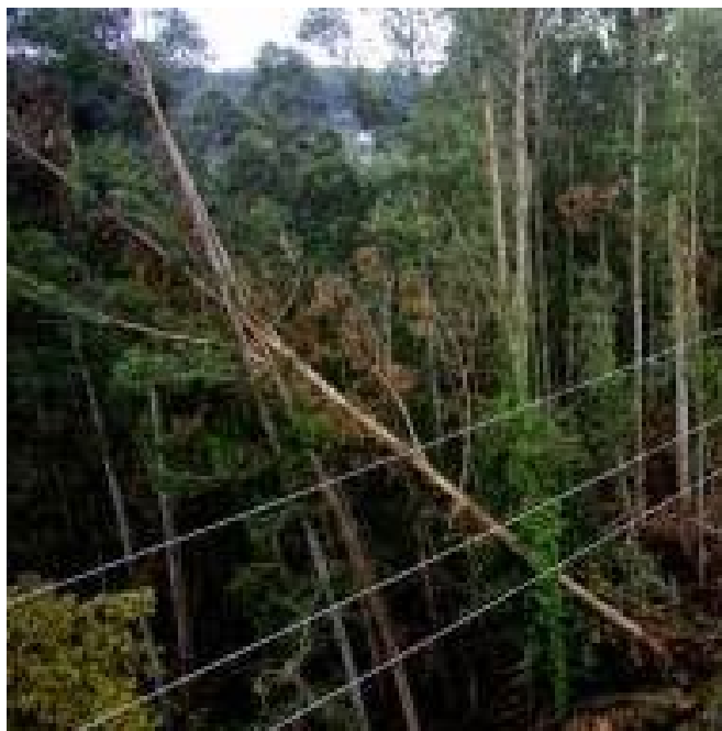
FIGURA 7: EJEMPLO DE GENERACIÓN DE BIOMASA EN LAS LABORES DE LIMPIEZA DE LAS LÍNEAS DE TRANSMISIÓN ELÉCTRICA.
