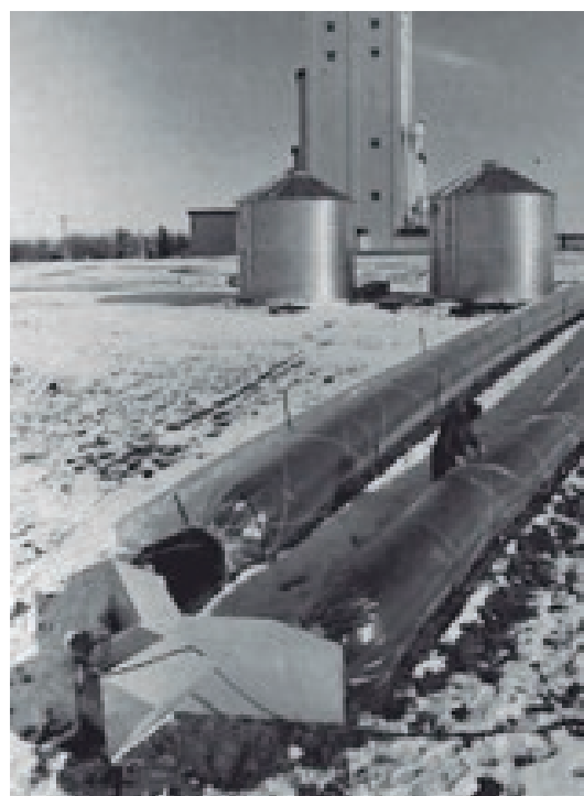
FIGURA 13. COLECTOR SOLAR DE TUBO DE PLÁSTICO. INFLADO PARA CALENTAR AIRE PARA SECADO DE GRANOS.
